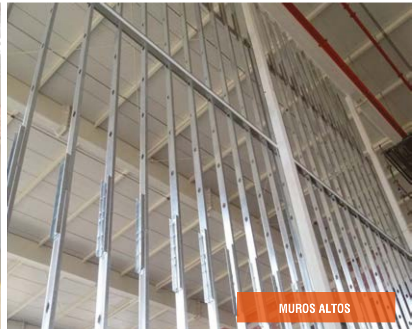
MURO PORTANTE CON ESTRUCTURA DE ACERO
